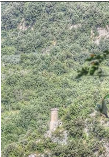
Torre colombaia in Valle Orsara
